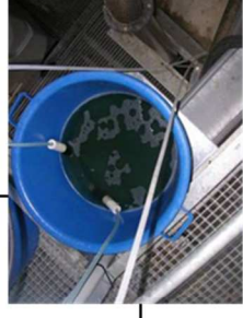
Bac de solution et crépines de pompage
